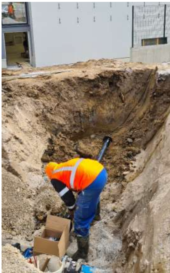
Montaža novega hidranta in prikllop za Plezalni center
