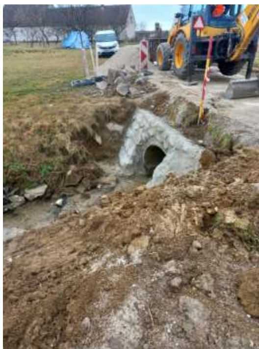
Sanacija prepusta na lokalni cesti v Zg.Polskavi
