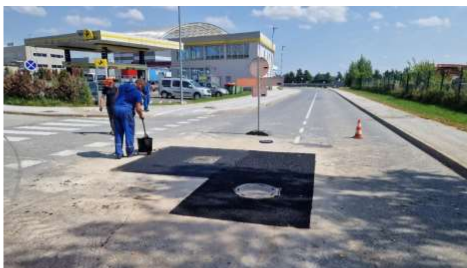
Sanacija kanalizijskih pokrovov v Žolgarjevi ulici
