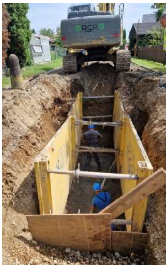
Izgradnja kanalizacije v Njivercah
