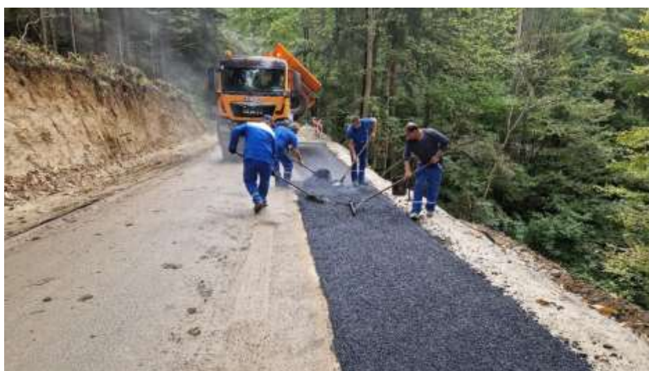
Asfaltiranje vozišča na sanaciji plazu ob lokalni cesti Tinje - Planina
