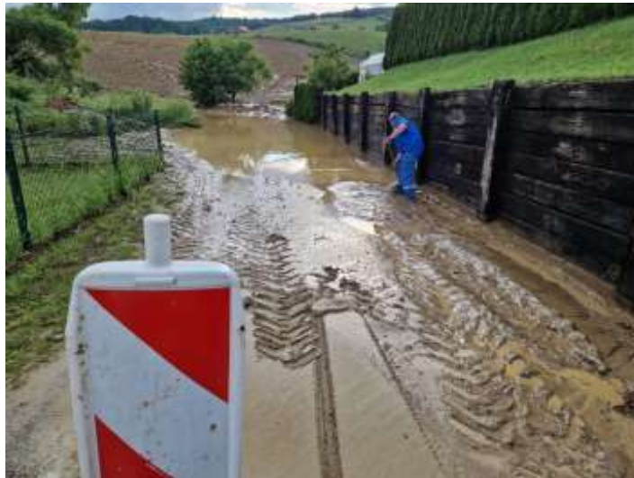
Elementar avgusta 2023 na poplavljeni lokalni cesti Kovača vas - Devina
