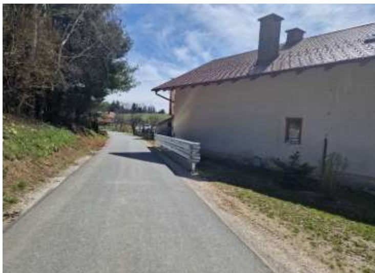
Postavitev jeklene varnostne ograje za zaščito objekta na lokalni cesti v naselju Ošelj
