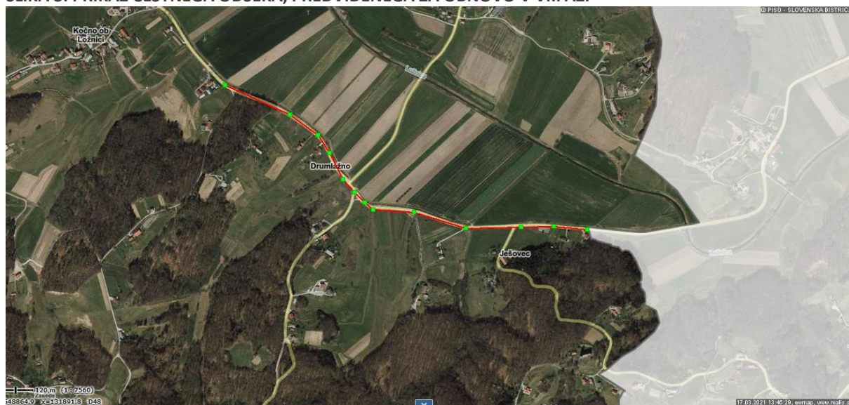
SLIKA 3: PRIKAZ CESTNEGA ODSEKA, PREDVIDENEGA ZA OBNOVO V VI.FAZI
